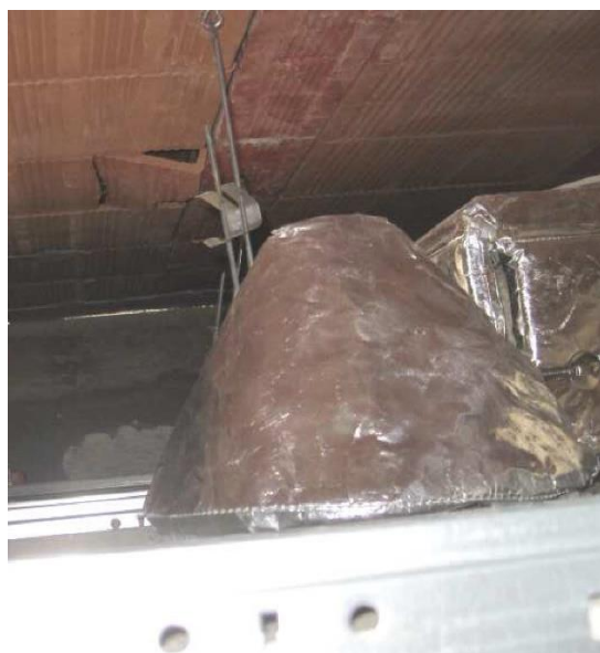
Figura 1 - Esempio di installazione Isol Cap P su faretto
