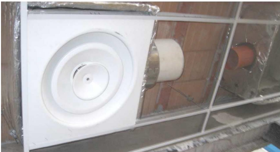
Figura 6 - Esempio di installazione 1 Isol Scat Collar con attacco laterale
