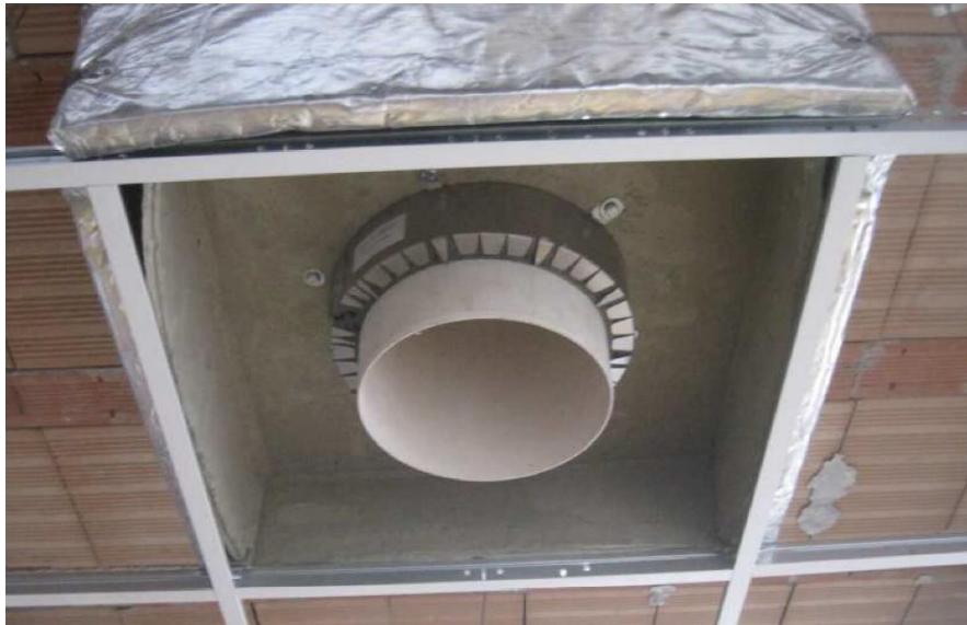
Figura 3 - Esempio di installazione 1 Isol Scat Collar con attacco superiore
