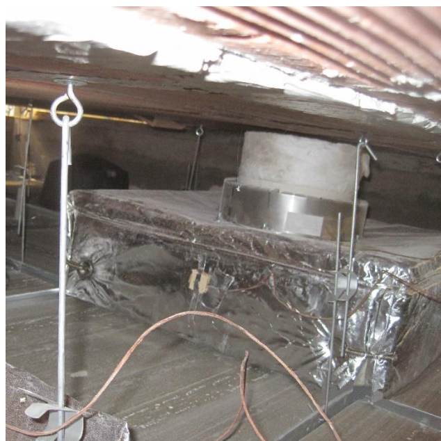
Figura 5 - Esempio di installazione 3 Isol Scat Collar con attacco superiore
