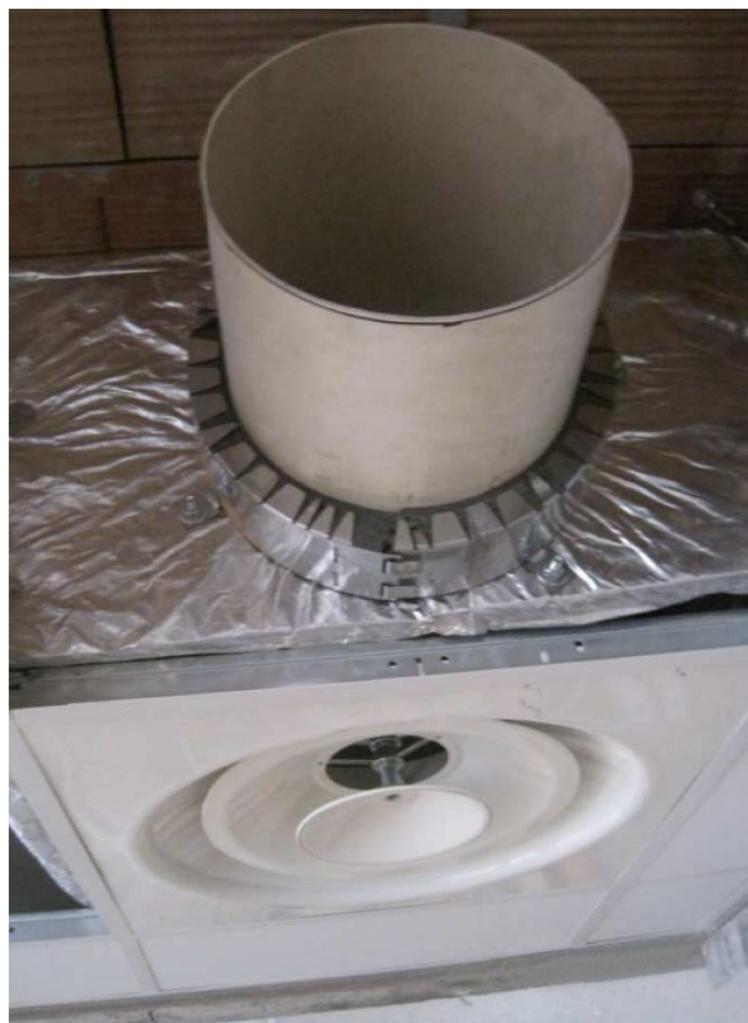
Figura 7 - Esempio di installazione 2 Isol Scar Collar con attacco laterale
