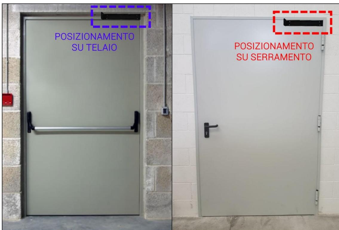
Figura 35 - Posizionamento della base di fissaggio del Master White su telaio (sx) o serramento (dx)
