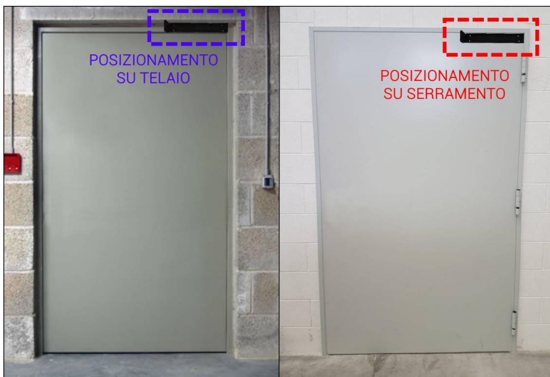
Figura 17 - Posizionamento della base di fissaggio del Master White su telaio (sx) o serramento (dx)
