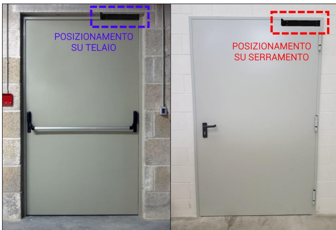
Figura 33 - Posizionamento della base di fissaggio del Master White su telaio (sx) o serramento (dx)
