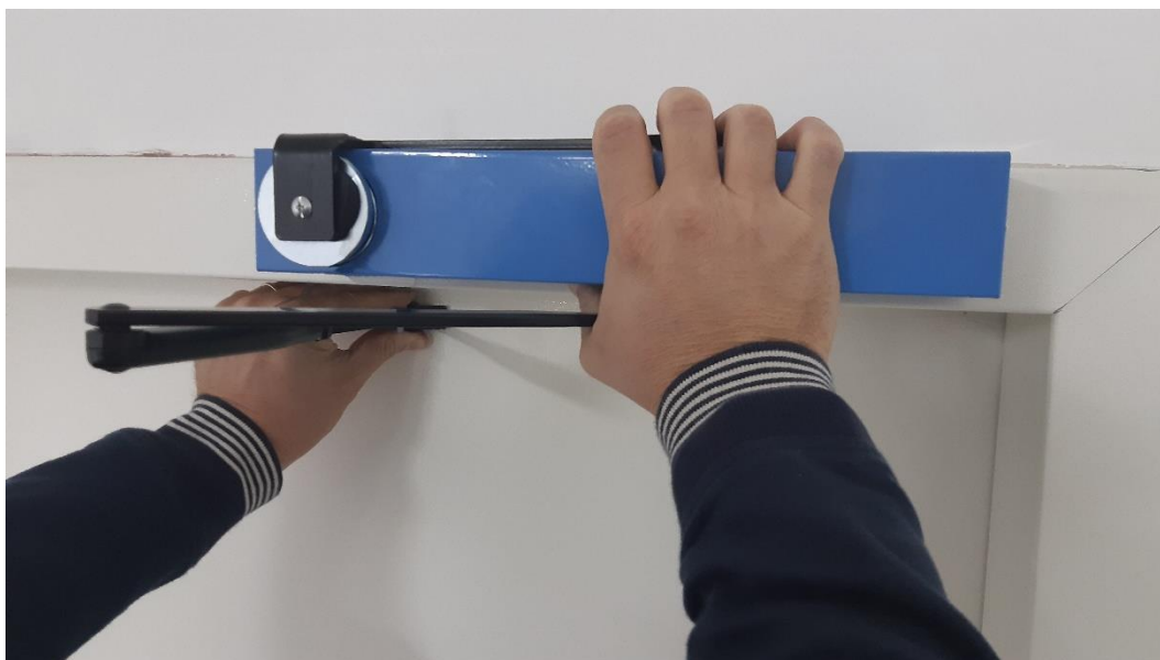
Figura 28 - Presentazione del Master White su serramento (utilizzare anche l'apposita dima)
